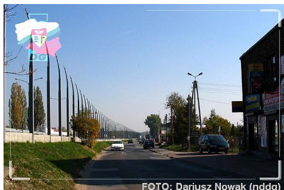
12.10.2005 - DG - Staszic. Ulica Strzemieszycka. Budowa ekranów dźwiękochłonnych. FOTO: Dariusz Nowak (nddg)
