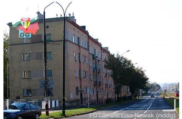
11.10.2005 - DG - Gołonóg. ul. Piłsudskiego. Pierwsze bloki mieszkalne.
