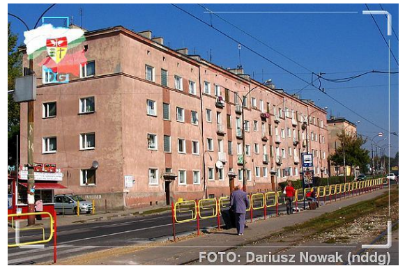
11.10.2005 - DG - Gołonóg ul. Piłsudskiego. Pierwsze bloki mieszkalne.
